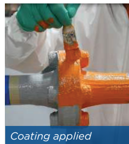
Belzona wrap applied
