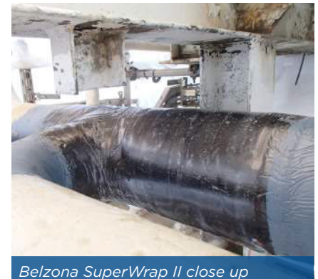
Belzona SuperWrap II close up
